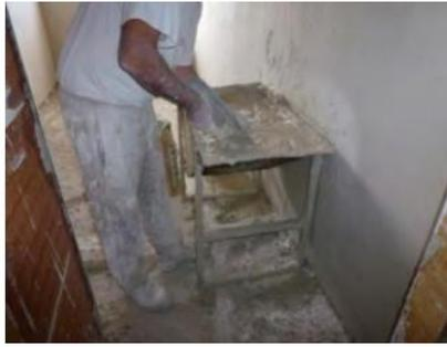
La utilización de **mesas auxiliares plegables, para cortar y adaptar los materiales** (paneles aislantes de poliestireno, lana mineral, placas de yeso laminado, perfiles, etc.) son una gran ayuda para poder realizar estas tareas en alturas adaptadas al propio cuerpo.
