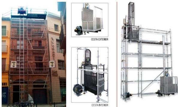
En obras de rehabilitación, con objeto de reducir las operaciones de transporte manual de cargas, y **minorar los daños en espalda, lumbares y en general el esfuerzo físico del trabajador**, pueden utilizarse **montacargas eléctricos de pequeña dimensión**, que
