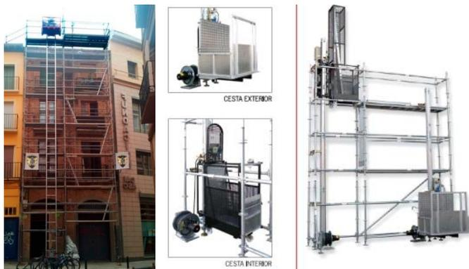
En obras de rehabilitación, con objeto de reducir las operaciones de transporte manual de cargas, y **minorar los daños en espalda, lumbares y en general el esfuerzo físico del trabajador**, pueden utilizarse **montacargas eléctricos de pequeña dimensión**, que ocupan poco espacio y su diseño, permite tanto el montaje con cesta exterior, como la instalación con cesta interior.
