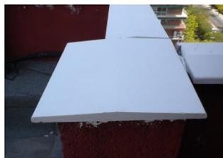
**Utilizar materiales fabricados con hormigones polímeros**. Estos materiales, por su aligeramiento, permiten reducir los esfuerzos corporales ante la necesidad de realizar un transporte manual de cargas (tejas, albardillas, etc.) aliviando los **esfuerzos en espalda, manos y muñecas**.
