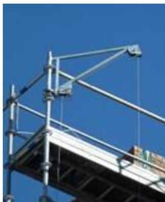
Cuando se montan andamios, o una vez instalados estos, es preciso elevar materiales y herramientas hasta las alturas de trabajo. Cuando no hay grúas de apoyo, es bastante común utilizar poleas y cuerdas. Sin embargo este sistema requiere la intervención manual de los trabajadores, siendo foco frecuente de fatigas musculares y sobreesfuerzos que se traducen después en **lesiones musculares y dolores lumbares y espalda.** En la actualidad, existen
