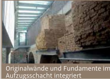
Originalwände und Fundamente im Aufzugsschacht integriert
