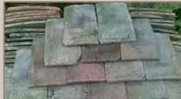
Auswahl und Reinigung der Fliesen, um sie in einem zweiten Mal wieder zu verwenden
