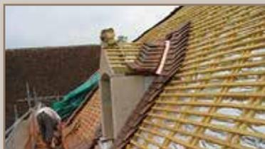
Verlegung von 12 dünnen Isolierschichten Stützlatzen
