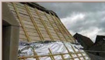
Verlegung von 12 dünnen Isolierschichten
