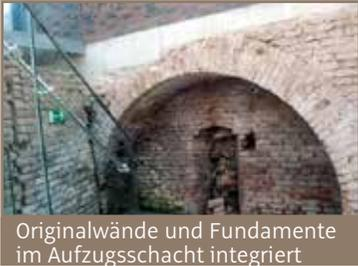
Originalwände und Fundamente im Aufzugsschacht integriert
