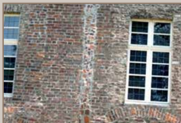
Rotura reparada en la fachada
