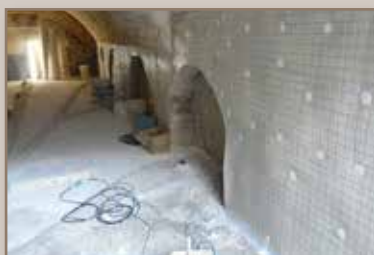
Restauración de la mampostería
