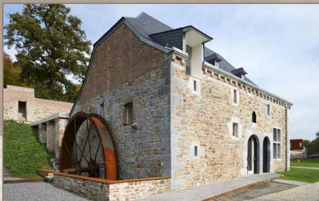
Después de la rehabilitación
