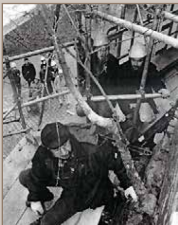
Retirando el abedul con raíz en la mampostería
