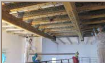
Restauración del techo
