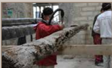
Restauración de traviesas
