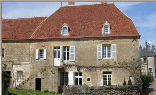
Después de la rehabilitación
