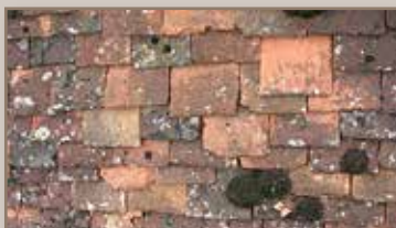
Elección y limpieza de las tejas para usarlas de nuevo
