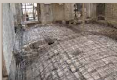
Cúpulas de consolidación
