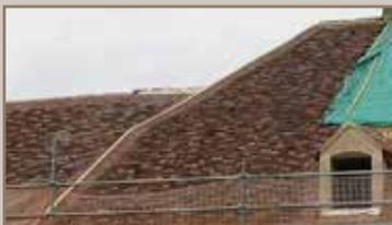
Miscela di piastrelle antiche e nuove e realizzazione dell'angolo centrale del tetto mansardato
