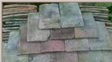
Scelta e pulizia delle piastrelle al fine di utilizzarle una seconda volta
