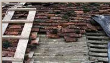
Levantamento e remoção das telhas
