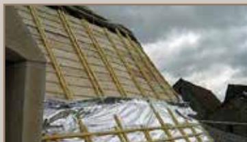
Instalação das 12 camadas de revestimento de isolamento
