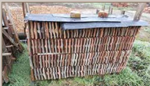
Remoção e armazenamento da telha do cume e remoção dos suportes e testemunhos danificados
