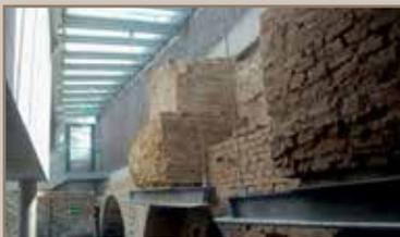
Paredes originais e fundações integradas no eixo do elevador
