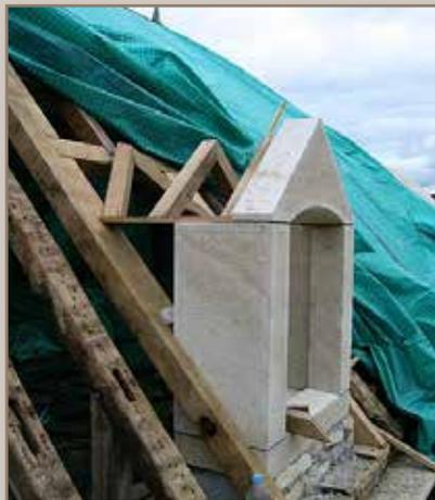
Cópia da claraboia existente e correspondência dos elementos para reinstalação no espaço existente
