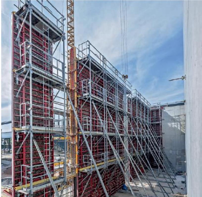
*Fig. 3. Barandilla de protección y parte de encofrado ensamblado [Fuente: PERI]*
