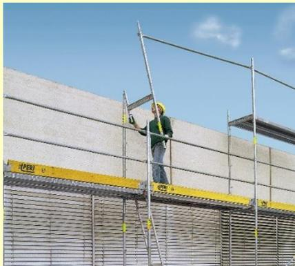
Fig.7 Desmontaje desde el nivel inferior. [Fuente: PERI]
