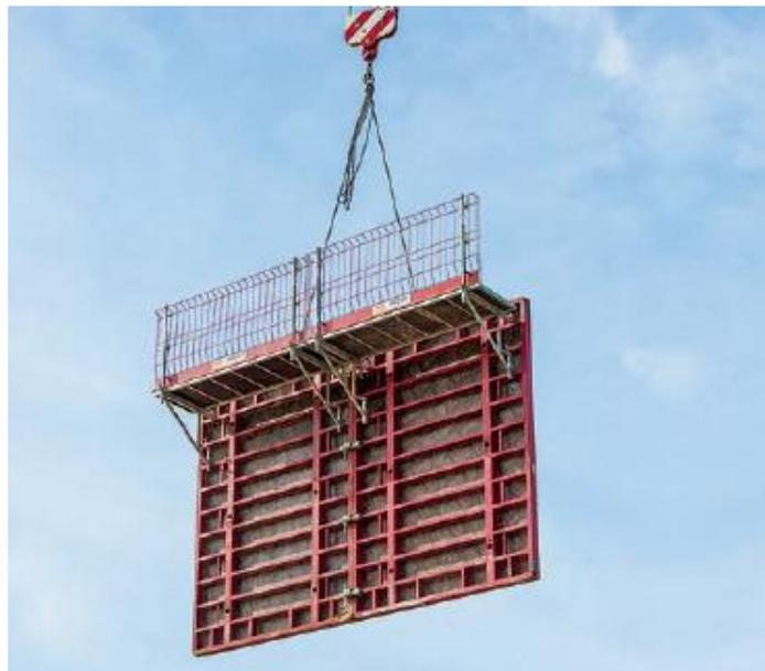
*Fig. 4. Transporte de paneles de encofrado ensamblados [Fuente: PERI]*
