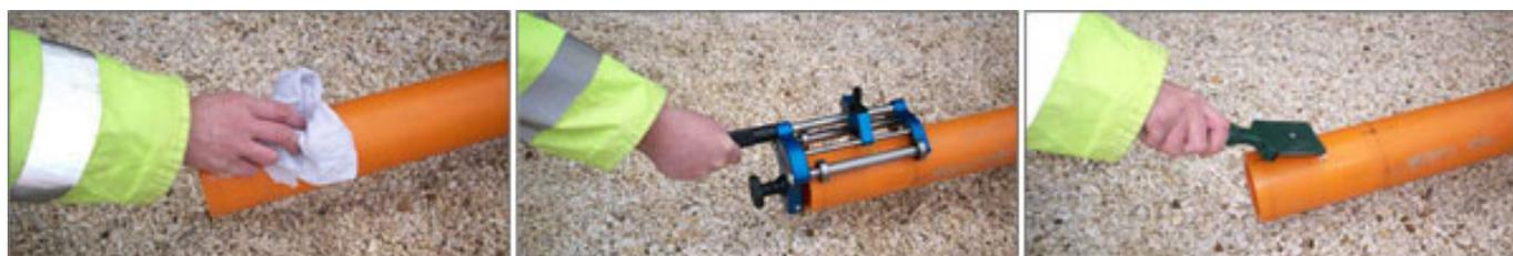
Figura 5. Soldadura por electrofusión. Fuente: <http://www.blogplastics.com>
