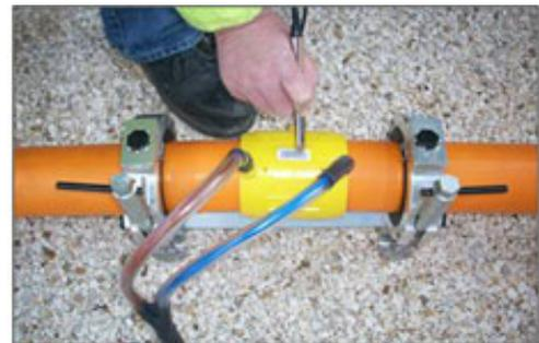
Figura 7. Soldadura por electrofusión. Fuente: <http://www.blogplastics.com>
