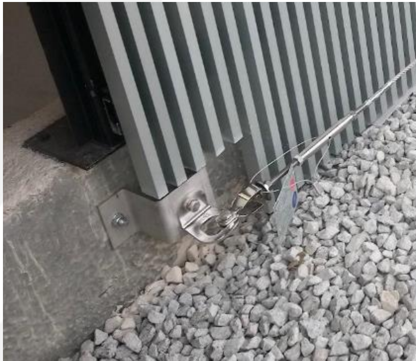
Solución sobre omega fijada lateralmente en muro de cubierta.
