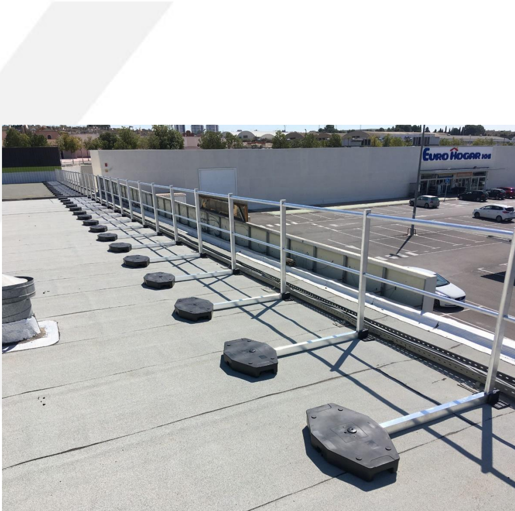
Barandilla fija contrapesada (EN14122-3)
