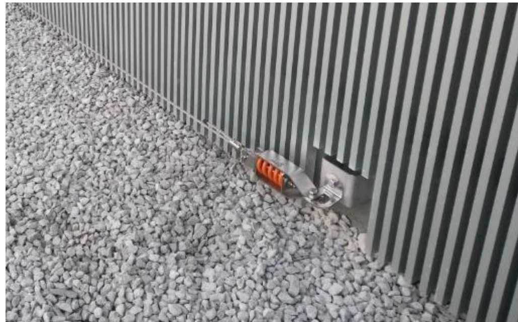
Solución sobre omega fijada lateralmente en muro de cubierta.
