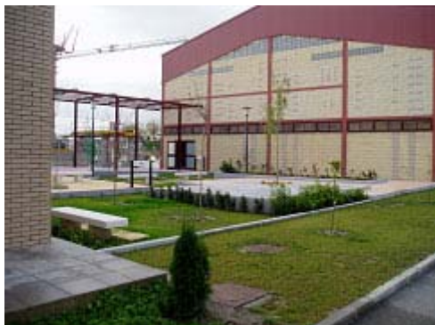
Nave de talleres de oficios administrativo
